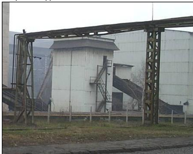
Слика V.1-13. Надземен цевковод
