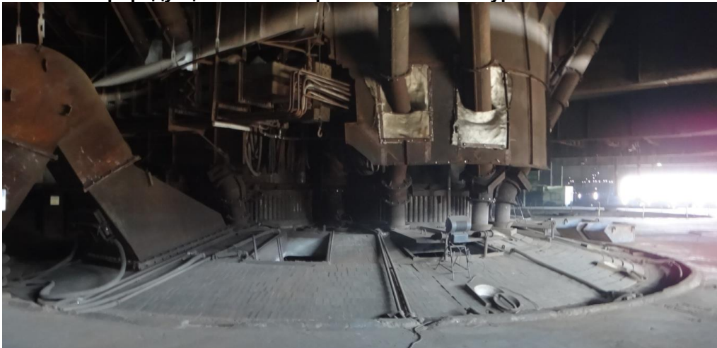
Слика II.1-4. Електроредукциона печка бр.4 во Скопски Легури
