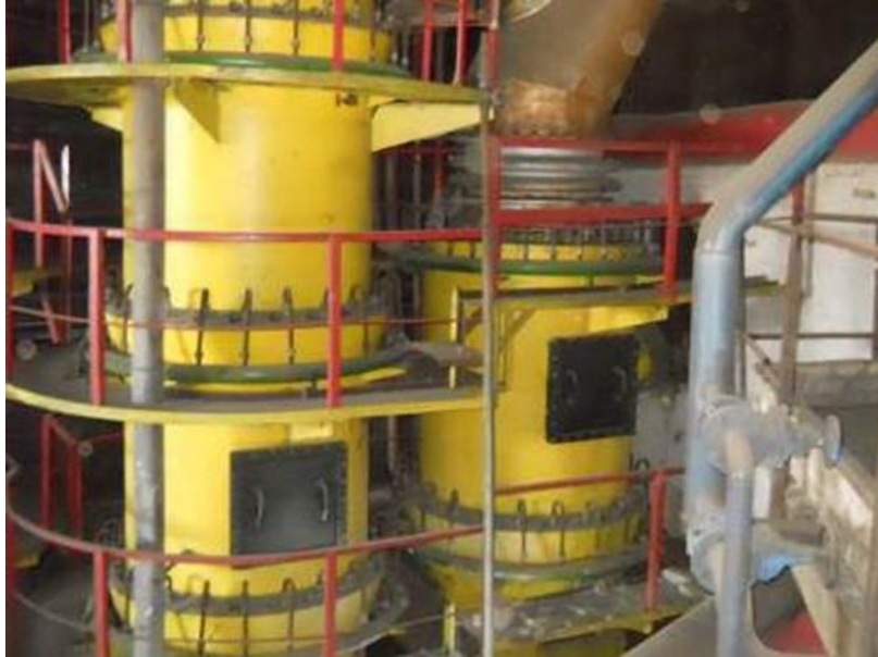
Слика VIII.2-5. Влезна и излезна цевка и водена запора
