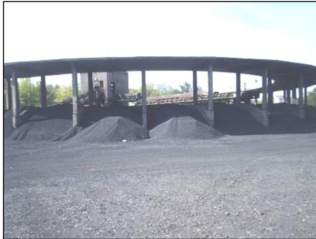
Слика V.1-12. Полуотворено складиште за кокс
